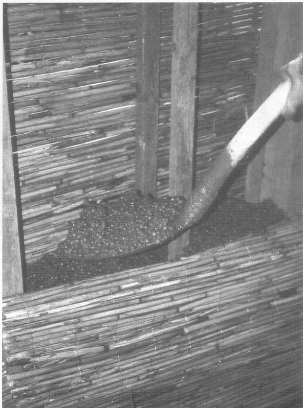
10.5-8 Vertido de barro aliviado con mineral en un encofrado perdido
