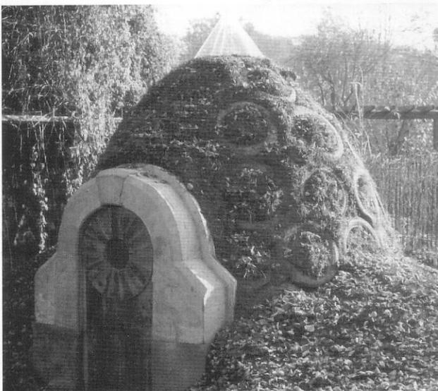
hilada (Figs. 8.4-20 a 8.4-22). Los elementos se fijan con un mazo para obtener un muro más homogéneo y una mejor cohesión. El acabado de la cúpula se hizo con un recubrimiento de una lámina de poliéster cubierta de PVC que ofrece una capa impermeable y permite colocar tierra y césped encima sin peligro de que las raíces penetren. Se emplearon llantas usadas de autos para evitar el deslizamiento del césped. Otras posibilidades para cubrir cúpulas de tierra se describen en la sección 14.7.
