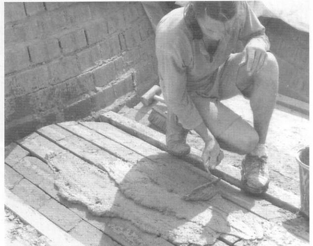
14.7-41, 14.7-42 Bóvedas con encofrado minimizado
