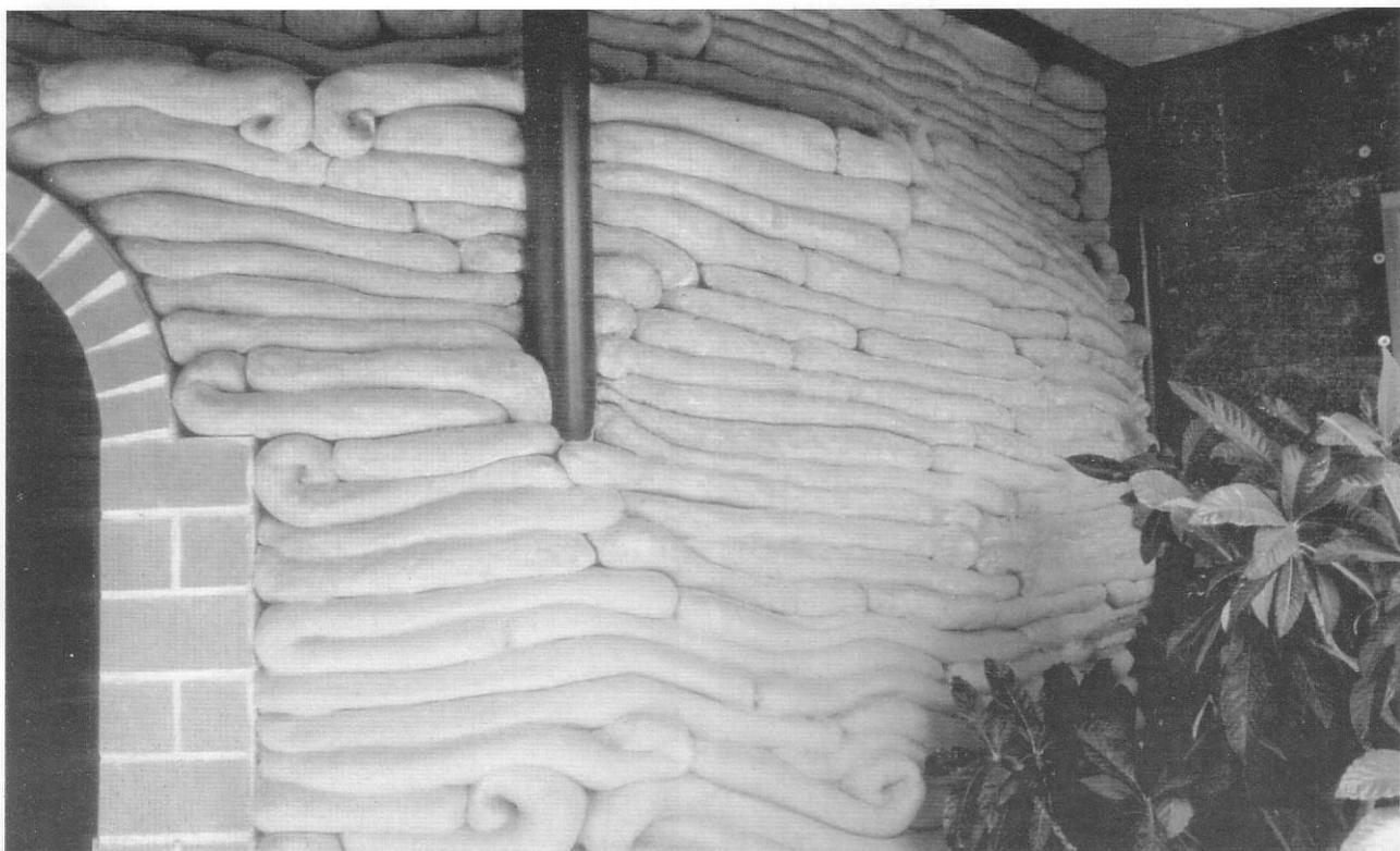
10.8-8 Muro de un invernadero hecho con mangueras rellenas con barro que almacenan calor y balancean la humedad
