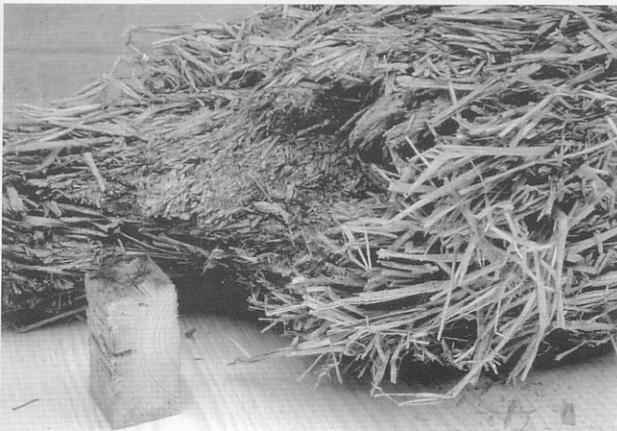
10.3-4 Parte interior en estado de descomposición de un muro de barro aliviado con paja
