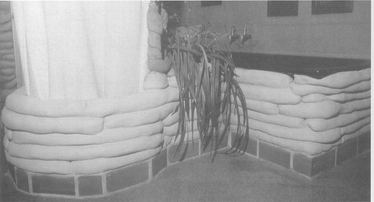
14.10-3 Objetos sanitarios recubiertos con mangueras rellenas con barro
