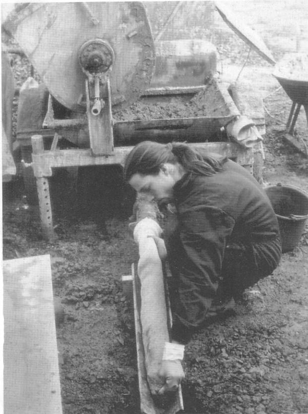
10.8-1 Relleno manual de mangueras con barro alivianado con mineral utilizando una bomba
