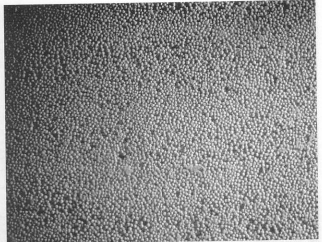
10.5-13 Superficie de un muro de barro alivianado hecho con barro arcilloso y arcilla expandida (8 a 16 mm) luego de desmontar en encofrado
