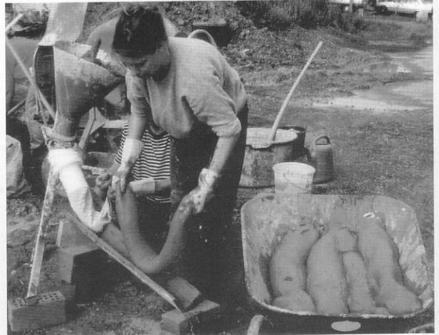
10.8-2, 10.8-3 Relleno de mangueras con barro alivianado con mineral utilizando un embudo
