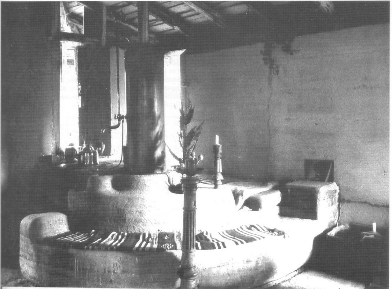
14.11-3 Cocina integrada con sistema de calefacción para una cama y un asiento
