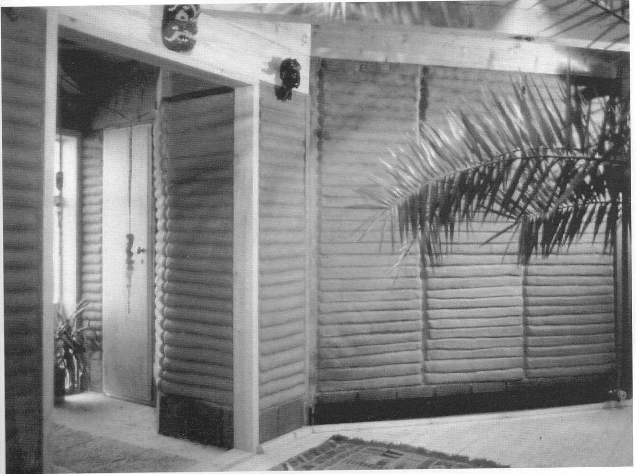
8.4-14 Muro interior hecho con perfiles de barro extruido
