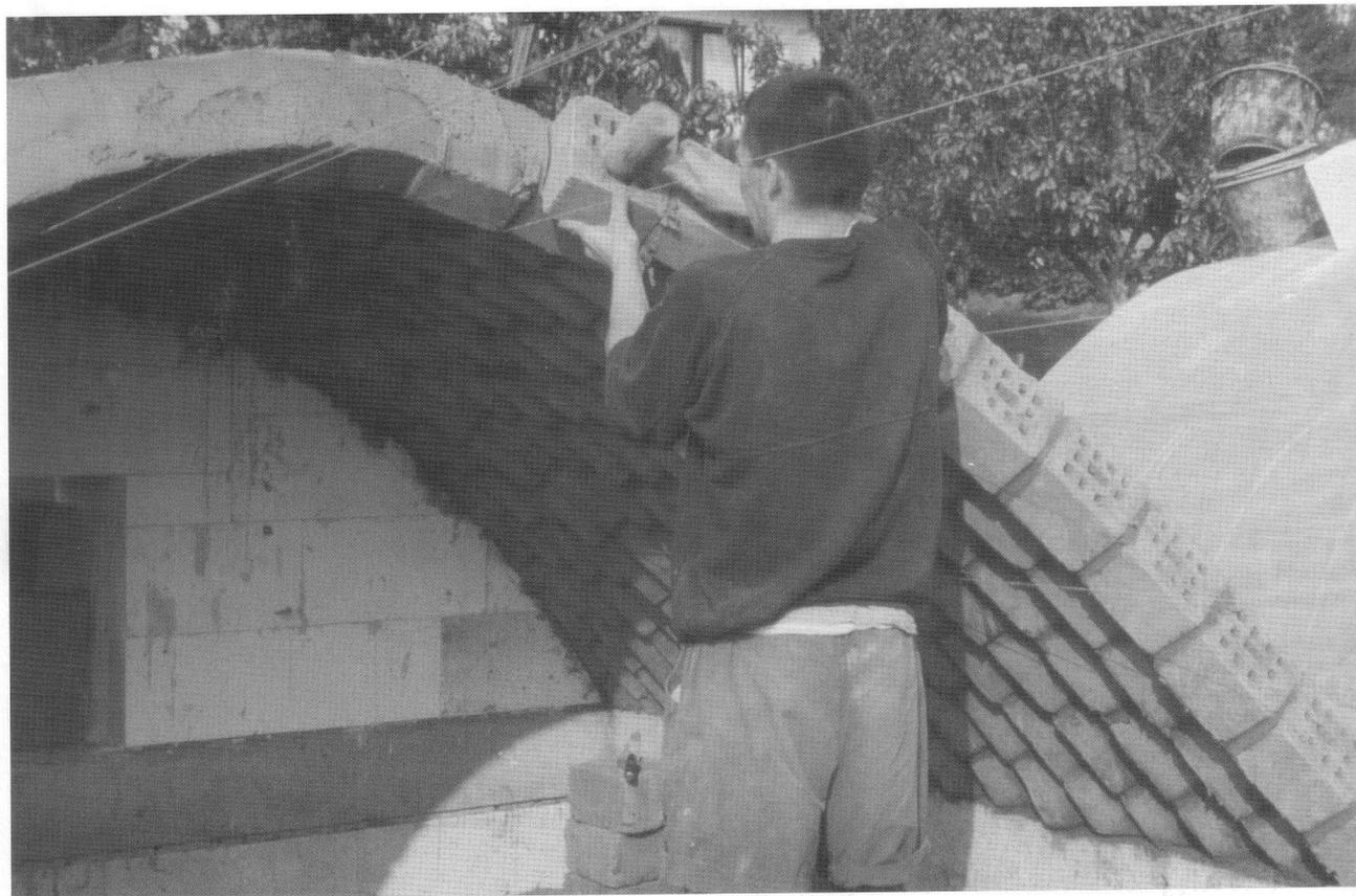
Las bóvedas tienen la sección de una catenaria invertida y están construidas con la técnica nubica con bloques de suelo no estabilizado. Los bloques tienen una forma cónica (con el objetivo de ahorrar mortero) y se produjeron en una fábrica.
