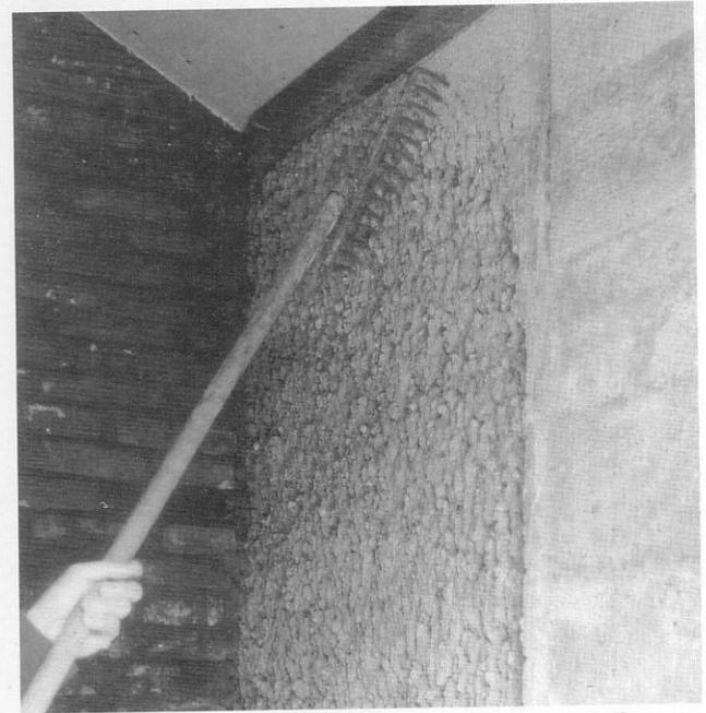
10.5-14 Raspado de una pared de barro alivianado con arcilla expandida para obtener una superficie con textura sin revoque
