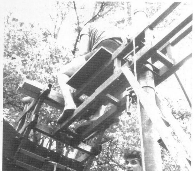
5.7-2. 5.7-3 Construyendo la cúpula de barro apisonado con un encofrado rotatorio
