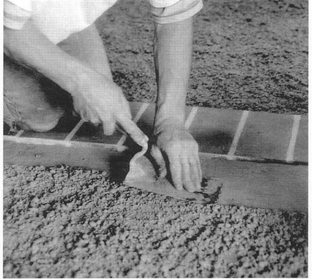
14.4-8, 14.4-9 Ejecución de pisos de barro alivianado con mineral con un revoque de barro resistente al agua y a la abrasión
