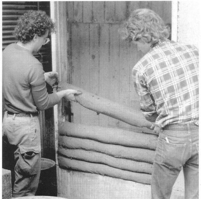
9.4-3 a 9.4-5 Método moderno para la elaboración de los rollos de paja y barro "Wickelstaken" (FEB)
