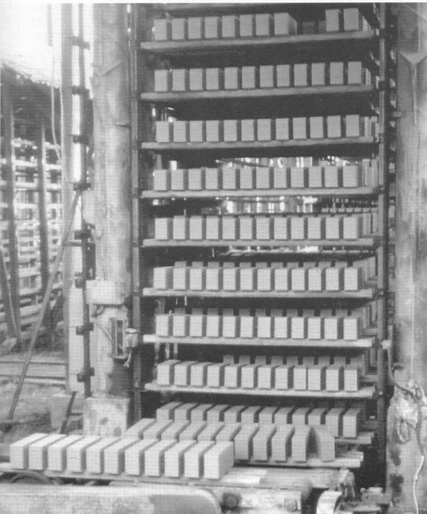
6.3-14 Secado de ladrillos crudos al aire libre en una ladrillera, Alemania
