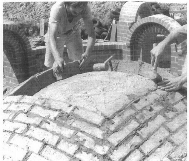
14.7-43 Cúpula con encofrado de arena húmeda
