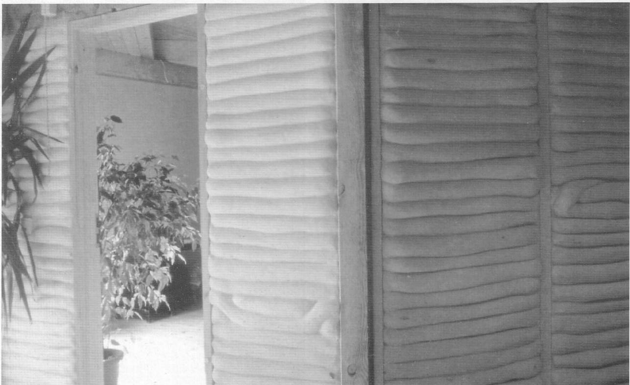
10.8-9 Muro interior hecho con mangueras rellenas con barro
