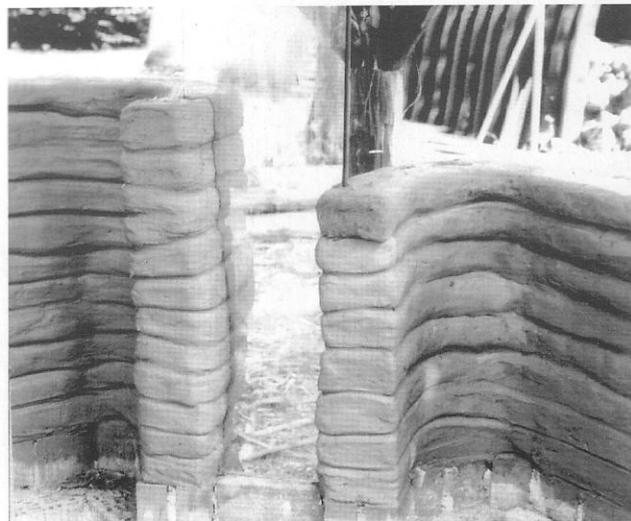
8.4-3, 8.4-4 Muros de perfiles de barro extruidos, casa de ensayo, Universidad de Kassel, 1982
